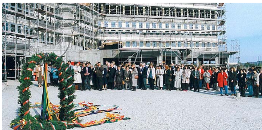
Im Oktober 1994 wird nach gut einem Jahr Bauzeit Richtfest gefeiert.
